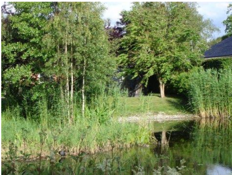
Fig. 3: Lignende ”brinksikring” udført i vinteren 2011/12 på Åvej 20A, fotograferet ultimo juni 2014.
