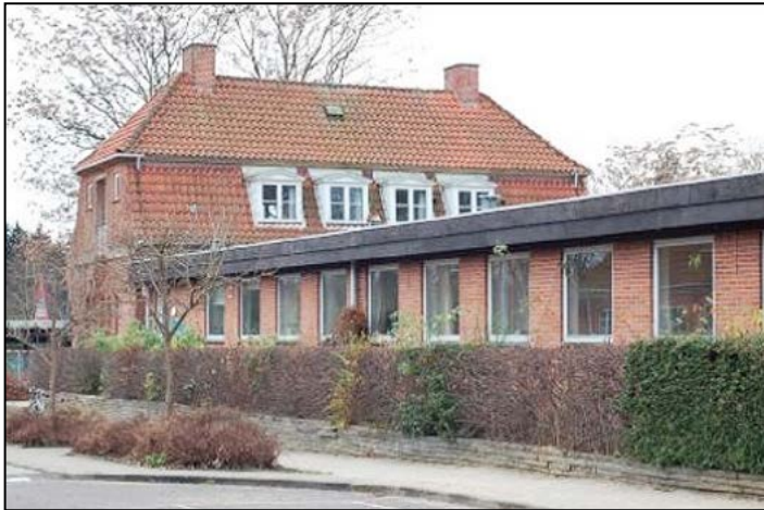
Bygningen bagerst er fra 1934 - forrest fra 1974.
